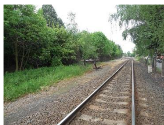
Gymnázium – spojnice mezi ulicemi Komenského a Kloudova Nástup od ulice Komenského
